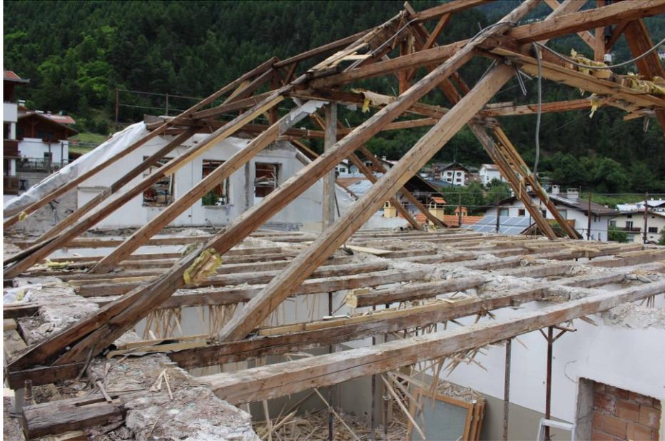
Die alten Dachträger nach der Ab Montage des Daches, Des schlechten Zustandes wegen, sind sie ersetzt worden
