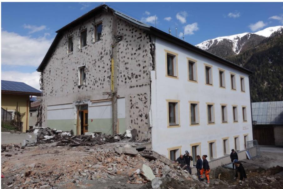
Das Abtragen der alten Dämmschicht an der Nord-West Fassade
