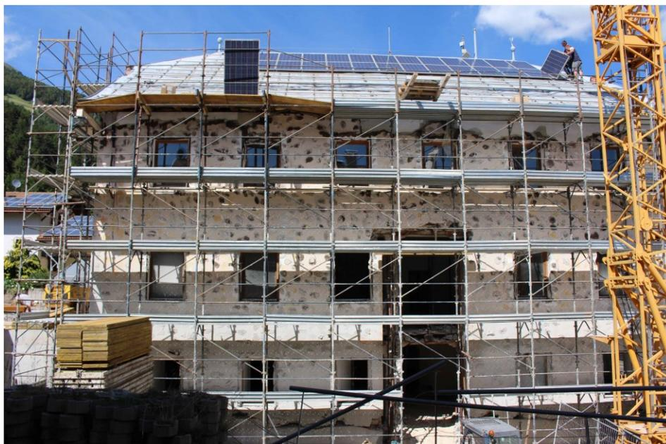
Neue Öffnungen werden an der Hauptfassade realisiert
